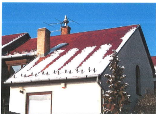
2. kép, 7. ábra Hőhidasság kialakulás tetőtérben faszervezet mentén
