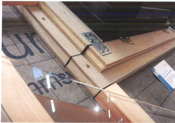
4. kép Tetősík ablak beépítése hőszigetelő alátét keretre
