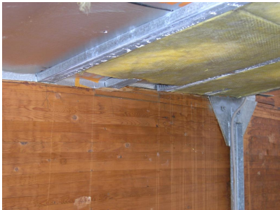
Fém bordák csavaros rögzítése
