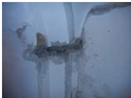
Az acéllemez szigetelés felső széle
