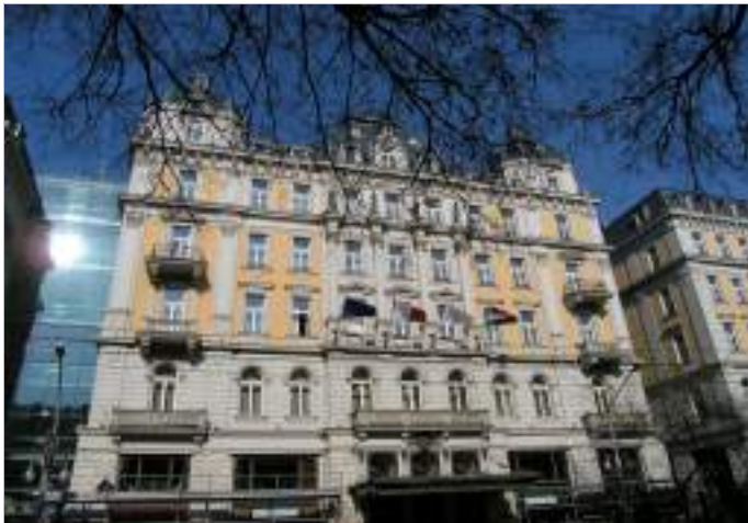
Corinthia Grand Hotel Hungária - lágy PVC teknőszigetelés + vb.ellenszerkezet + injektálás
