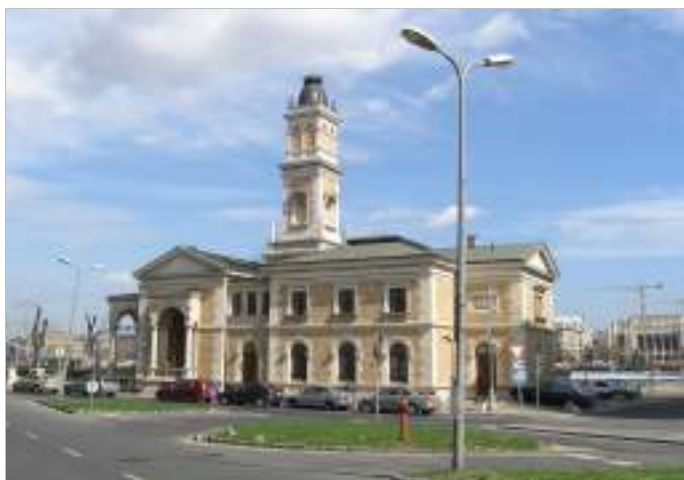
Várkert Kaszinó – hegesztett acéllemez szigetelés behorgonyozva + „injektálás”
